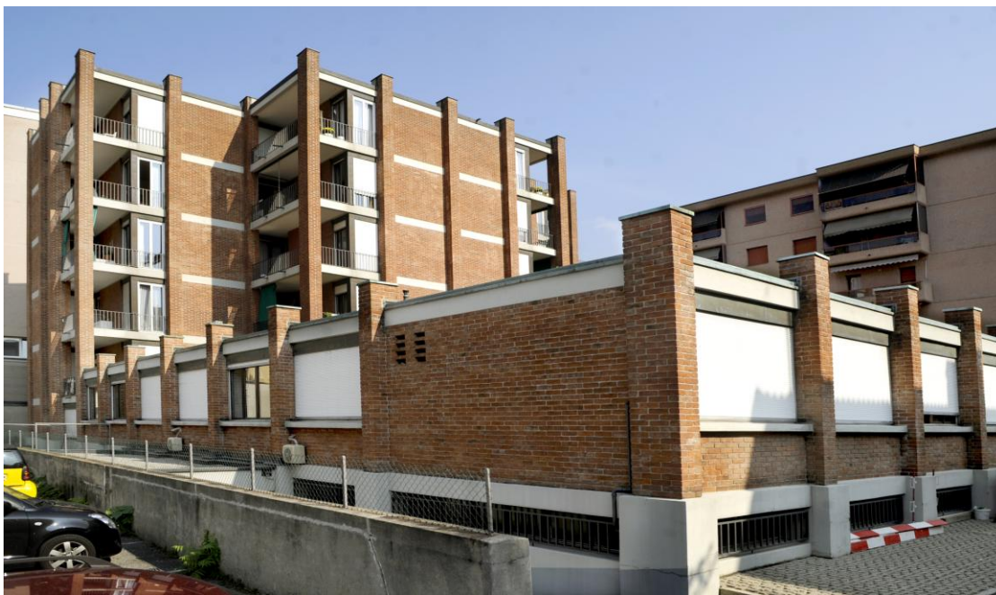
Lo stabile della Fondazione in via Vanoni, progettato dagli architetti Carloni e Camenisch, in cui si trovano appartamenti d'affitto e gli spazi dell'ex casa per anziani, ora occupati dalla Pro Senectute (Foto Samuel Golay).
