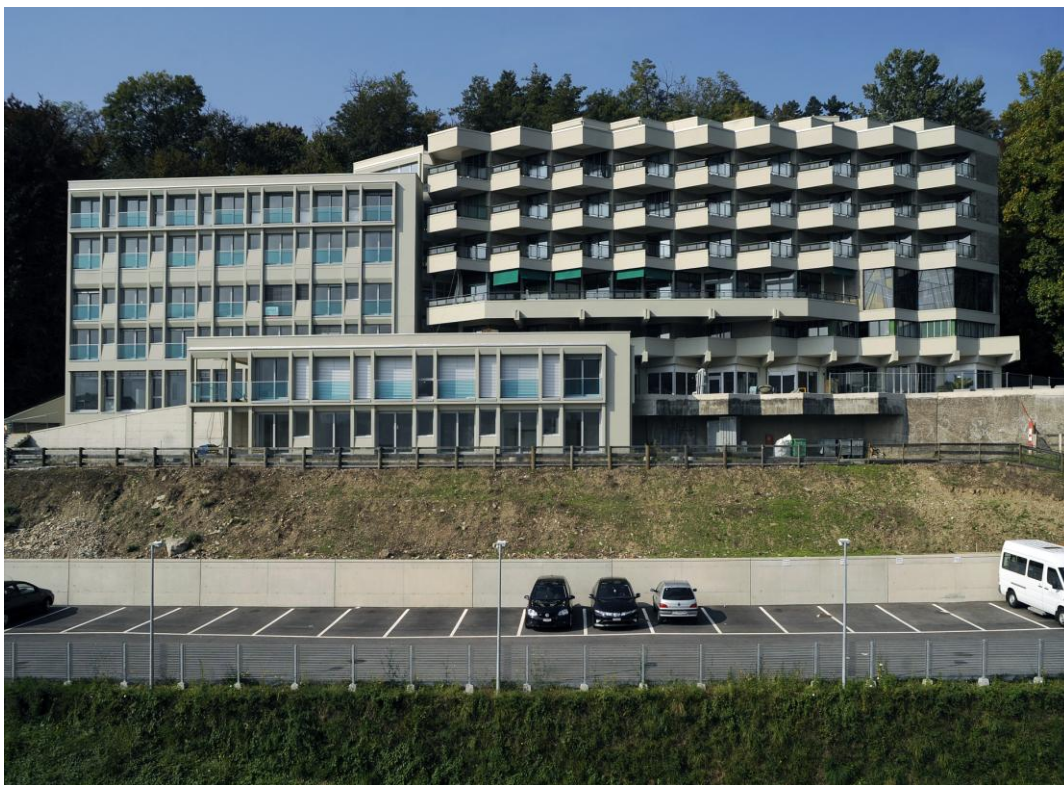
Ca' Rezzonico come si presenta oggi: a destra l'edificio progettato dall'architetto Finzi, a sinistra e davanti l'ampliamento dell'architetto Nobile (Foto Samuel Golay)
